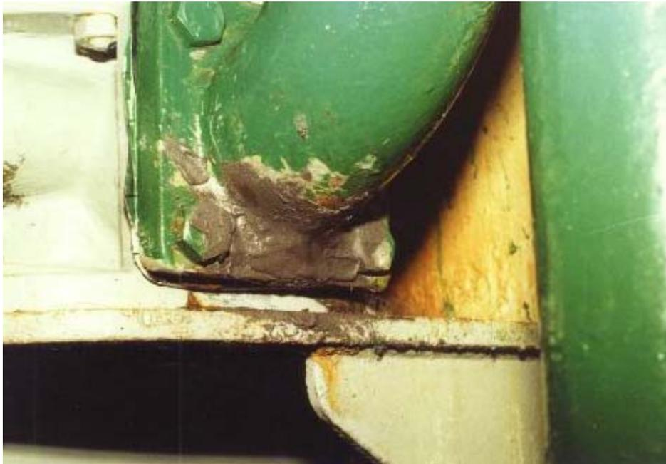
Instandsetzung einer unter Druck stehenden Wasserleitung mittels MM-metall UW und Härter UW3. Die Abdichtung erfolgte bei austretendem Wasser.
