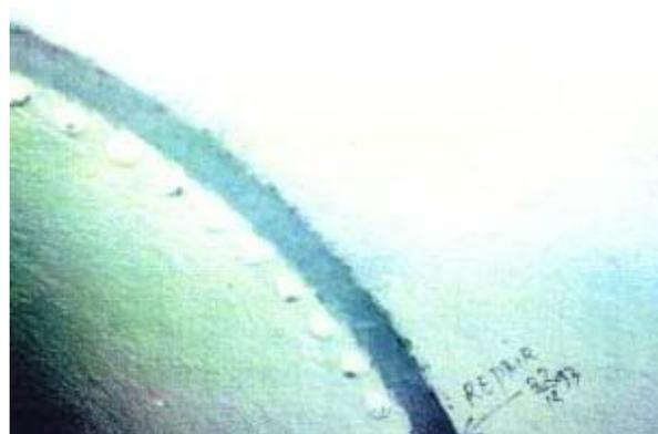
Die innere und äußere Oberfläche einer Druckleitung mit Durchmesser ca. 1,5 m, Länge ca. 900 m wies Schäden auf. Diese wurden durch Erosion und Abrasion auf der Basis von Sand und Wasser verursacht. Eine Instandsetzung erfolgte mit Ceramium, pastös und Härter CE.
