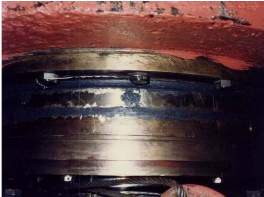
Reparatur einer undichten Simplex-Kompaktdichtung. Aufgrund von austretendem Öl wurde die Reparatur erschwert. Deshalb entschied man sich, das direct-MM-bonding Verfahren zu verwenden und das PolymerMetal direkt auf die ölige Oberfläche zu applizieren. Hier wurde MM-metall oL-StahlKeramik mit Härter rot verwendet.
